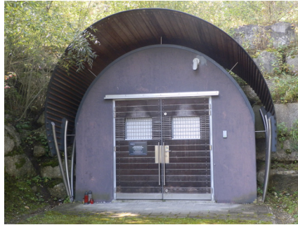
Gusen: Heutiger Eingang in die Stollenanlage, © Blaha
