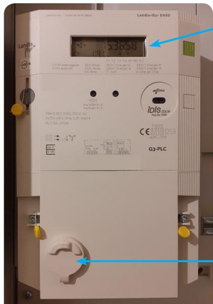
Moderne Zähler haben keine sich drehende Scheibe, sondern ein Digital-Display. Es zeigt uns abwechselnd mehrere Werte an. In der Abbildung wird ein Smartmeter der Fa. Landis Gyr e450 gezeigt. Österreichweit werden unterschiedliche Smartmeter eingesetzt. Alle weiteren Hinweise beziehen sich auf diesen Zähler, andere Zähler sind ähnlich ausgestattet.
