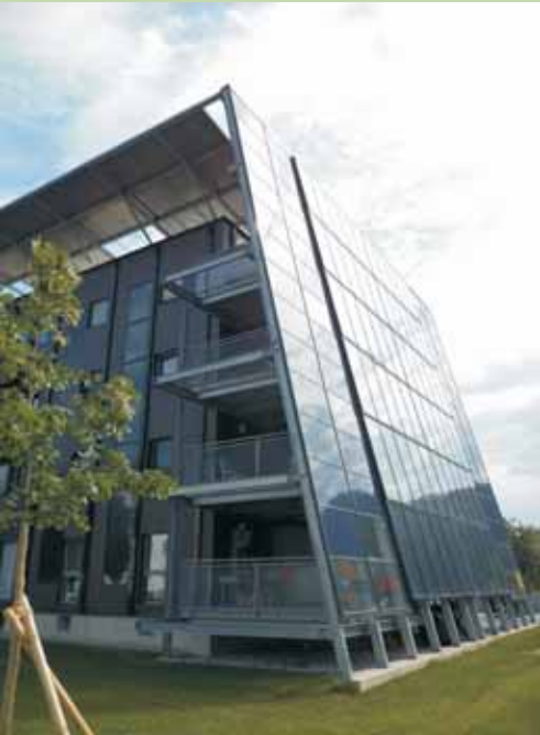
Sanierung einer Wohnhausanlage in Kapfenberg auf Plusenergie-Standard: Solarsegel. Quelle: AEE Intec
