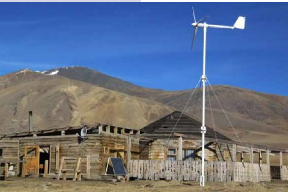
Erzeugung von Elektrizität mit Wind und Photovoltaik erbaut von Telenigits, einer indigenen Gemeinschaft im russischen Altai-Gebirge
