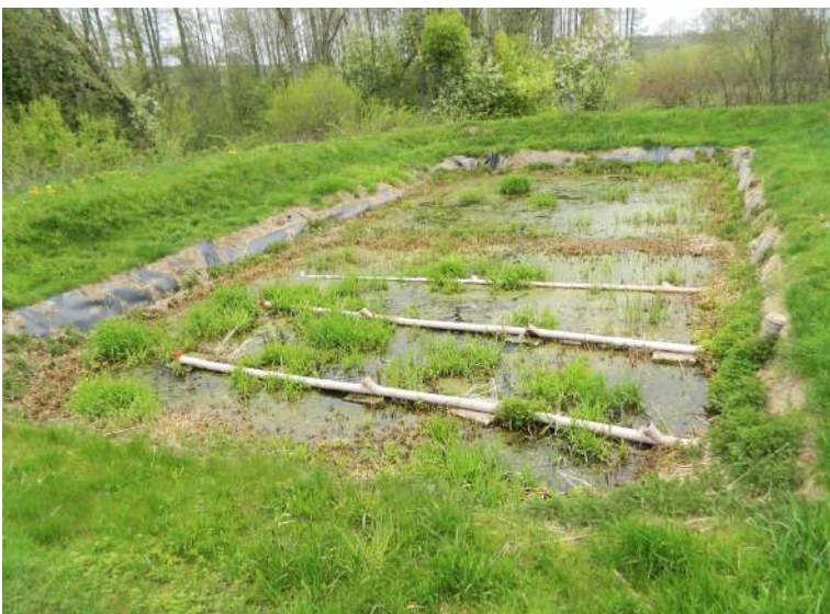
Pflanzenkläranlage bei der Firma Sonnentor in Sprögnitz (Niederösterreich)
