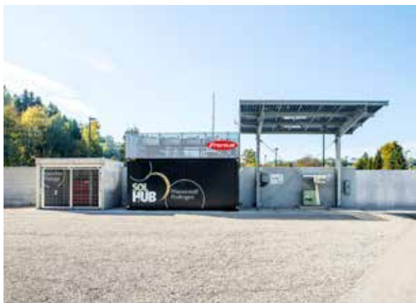
Solar-Wasserstoff-Tankstelle von Fronius in Thalheim bei Wels © Fronius International GmbH
