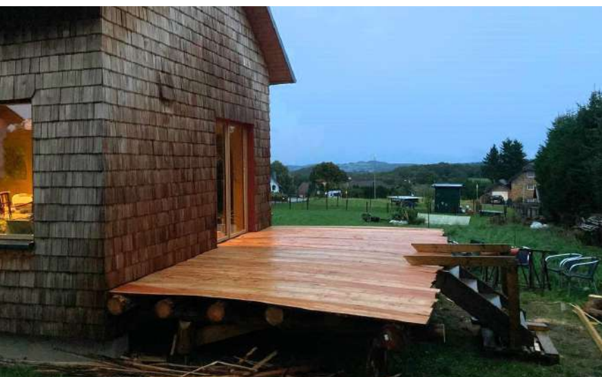
Tinyhaus mit Strohballendämmung und Lärchenholzschindeln in der Eifel
