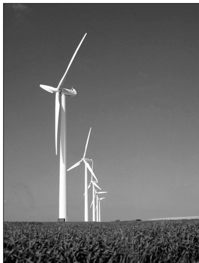
Eine derartige Windkraftanlage (5 NEG MICON) ist auch für Parndorf vorgesehen
