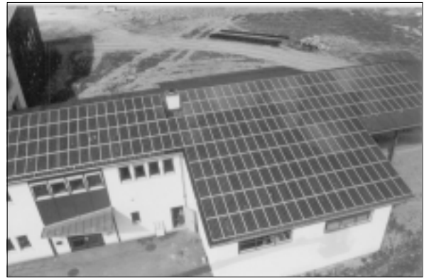
Abbildung 3: Die Photovoltaikanlage auf diesem Dach (Ökopark Hartberg) leistet 20kW und deckt den Strombedarf von 6 Einfamilienhäusern.
